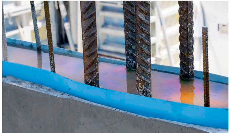
Rostband zwischen Bewehrung und Wandschalung in den weichen Beton stecken.
