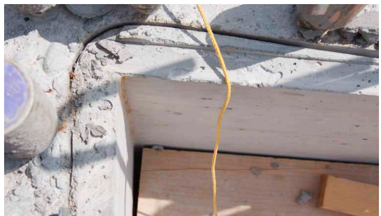
Nach dem Rausziehen hinterlässt Rostband eine schmale Fuge, die kurzzeitig als Wasserrinne dient.
