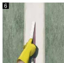
Das über der Fuge bzw. über dem Riss (mittig) liegende Klebeband entfernen.
