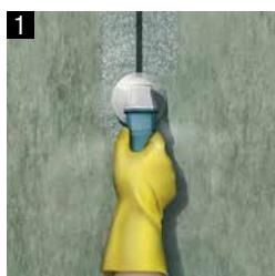
Untergrundvorbereitung mittels Sandstrahlen, Schleifen, usw., danach entstauben.
