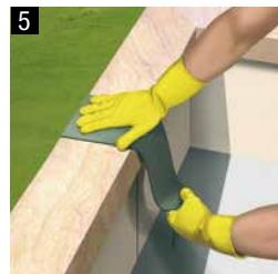
Dichtungsband auf Reparaturstelle andrücken (bei kühler Witterung Band erwärmen).
