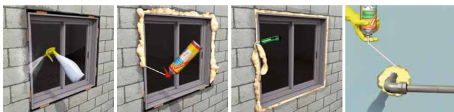
**Dämmstoffkleber für Pistole****Colle pour matériaux d'isolation, pour pistolet**
