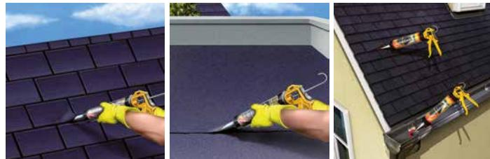
**Bitumen-Abdichtungsband****Bande d'étanchéité au bitume**
