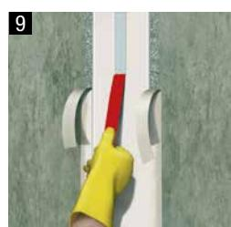
Klebebänder von den Fugenrändern sowie roten Mittelstreifen vom Sikadur-Combiflex® SG-Band entfernen.
