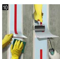
Bandstöße, L-Anschlüsse und Kreuzungen: 4–5 cm überlappen, **Schweissflächen anschleifen**, mit Heissluft unter Druck verschweißen.
