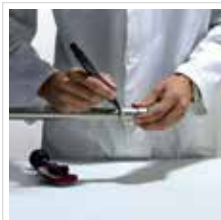
Fig. 17 Insertion des tubes dans les raccords et marquage
