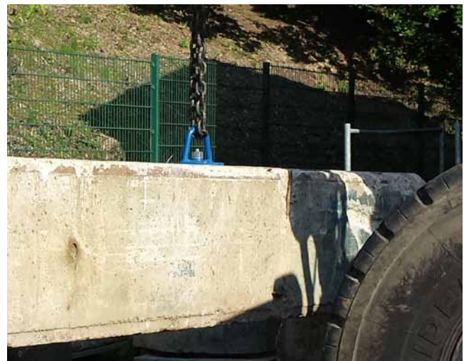
Transport von Betonteilen
