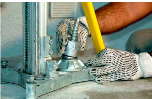
Befestigung eines Kernbohrgeräts
